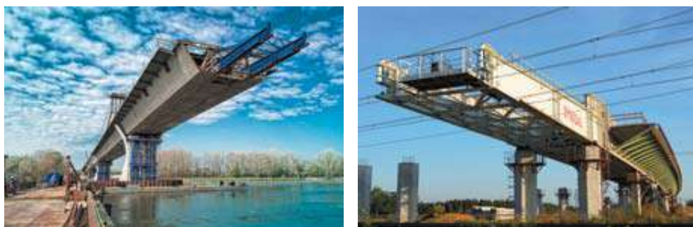
Rysunek 4.1. Mosty realizowane metodą nasuwania podłużnego: po lewej – stalowy most przez Wisłę w Kamieniu (fot. archiwum firmy Gotowski Budownictwo Komunikacyjne i Przemysłowe Sp. z o.o.), po prawej – estakada z betonu sprężonego w ciągu Obwodnicy Autostradowej Wrocławia (fot. J. Biliszczuk)
