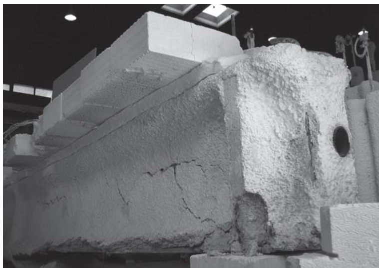
Rysunek 7.131. Obudowa dźwigara w Zakładzie Badań Ogniwych ITB – zdjęcie wykonane po badaniach (fot. Tomasz Rybarczyk)
