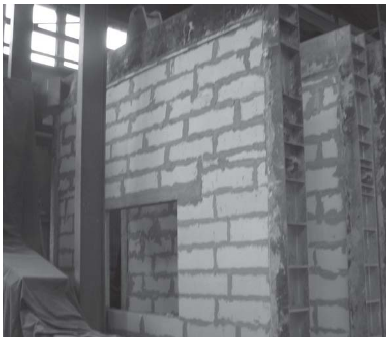
Rysunek 7.130. Beton komórkowy wykorzystany w Zakładzie Badań Ogniwych ITB do budowy stanowisk badawczych (fot. Tomasz Rybarczyk)
