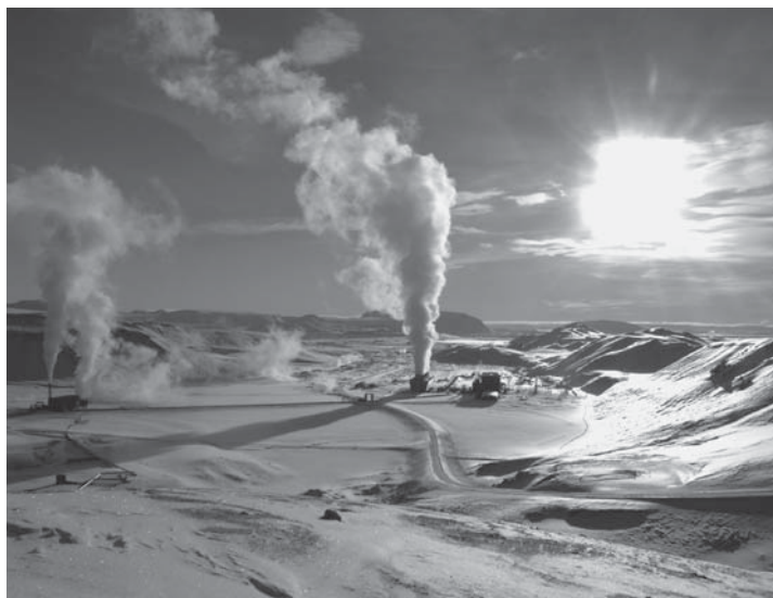
Rys. 28. Elektrownia geotermalna Krafla, Islandia
