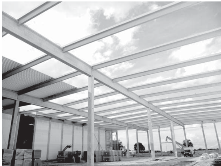
Rys. 26.7. Hala wielonawowa o układzie poprzecznym z pośrednimi płatwiami ułożonymi w kierunku podłużnym, kryta blachami falistymi [fot. Z. Pająk]
